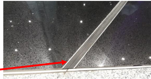
[열팽창 고려 일정간격 Expansion Joint 설치]
