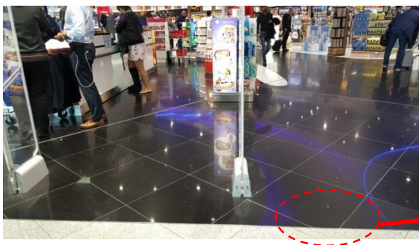
[열팽창 고려 일정간격 Expansion Joint 설치]
